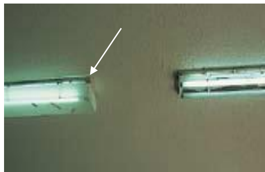
Κακή κατασκευή φωτιστικών σωμάτων (ετοιμόρροπο κάλυμμα, σκουριά). Θα πρέπει να δίνεται (από την επιβλέπουσα την κατασκευή των σχολείων υπηρεσία του ΟΣΚ) σημασία και στο εργοστάσιο παραγωγής (Ανατολική Χαλκιδική
