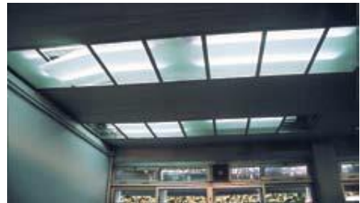
Η πτώση καλυμμάτων φωτιστικών σωμάτων (συνήθης πληγή στην Ελλάδα) μπορεί να γίνει και επικίνδυνη. Μήπως πέφτουν και οι λάμπες φθορίου; (Πάτρα 2000).
